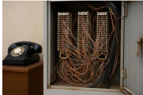
Caja de Empalme formada por regletas de empalme
